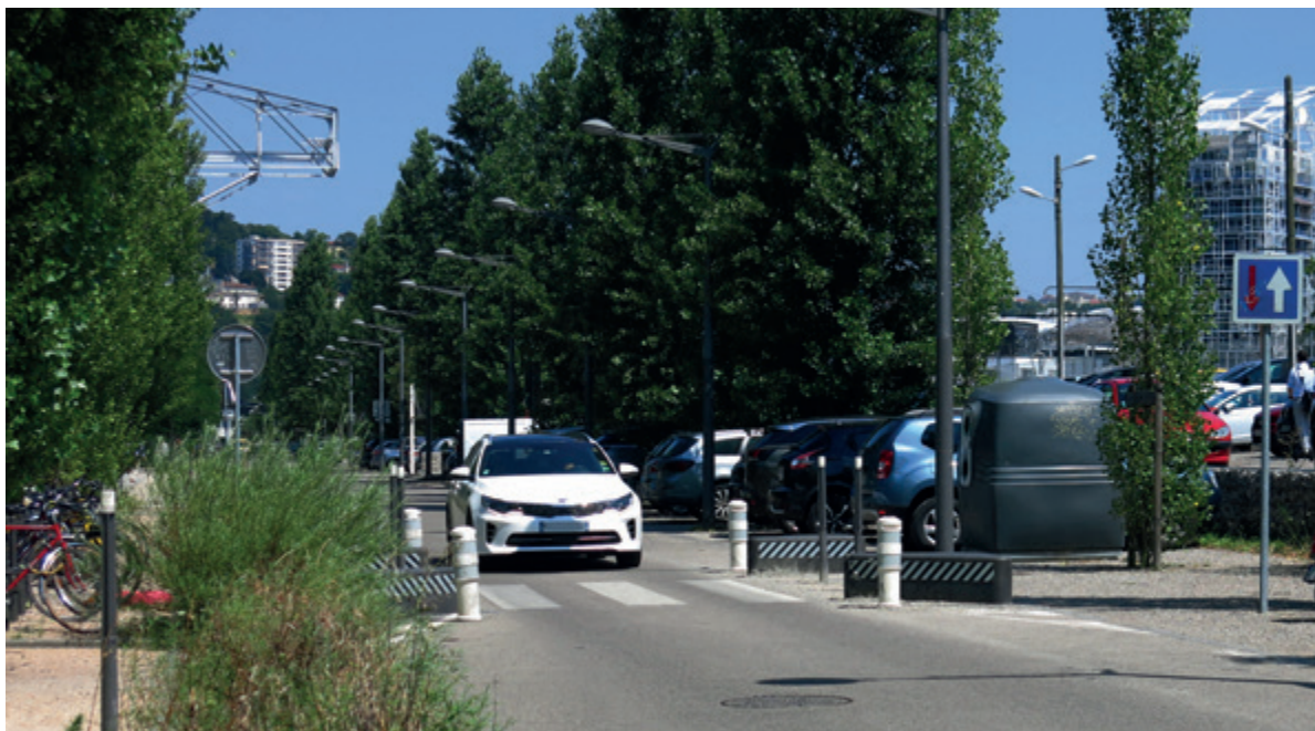
Ajout d'une écluse au niveau du passage piéton pour ralentir et faire ressortir la traversée piétonne.
