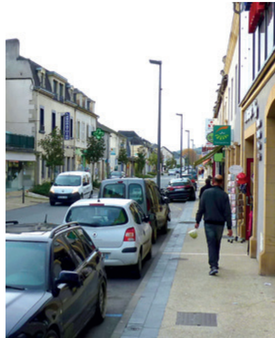
Mobiliers et éclairage public sont positionnés au niveau des zones de stationnement, afin de maintenir un cheminement sans obstacle pour les piétons. La proximité de ces équipements incite l'automobiliste à ralentir.
