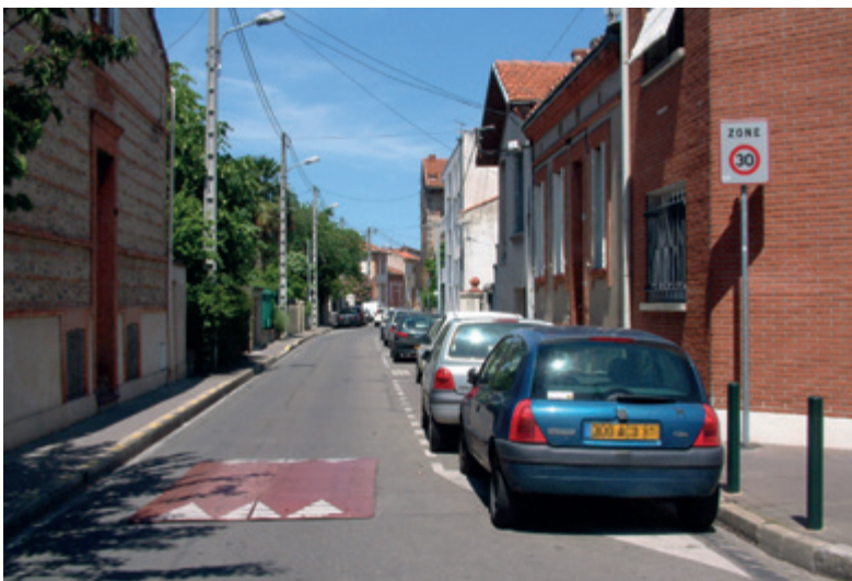
Coussin en entrée d'une zone 30
