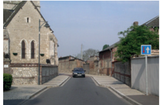
Ici, il s'agit d'une écluse simple avec rétrécissement axial : lorsque l'emprise n'est pas suffisante pour deux voies de circulation et deux trottoirs, le maintien de trottoirs confortables est possible.
