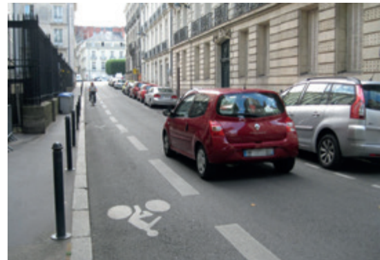
Dans cette rue plutôt large, l'aménageur a préféré réaliser un marquage séparatif pour délimiter le double sens cyclable.
