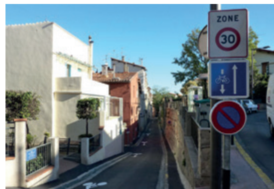
Les figurines cyclistes, avec flèches, sont répétées le long de la rue. Le double sens cyclable a été mis en place avec une largeur de chaussée de 3,2 m.
