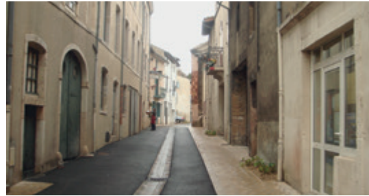
Les pieds de façade sont dégagés et peuvent être suivis par des personnes se déplaçant avec une canne.
