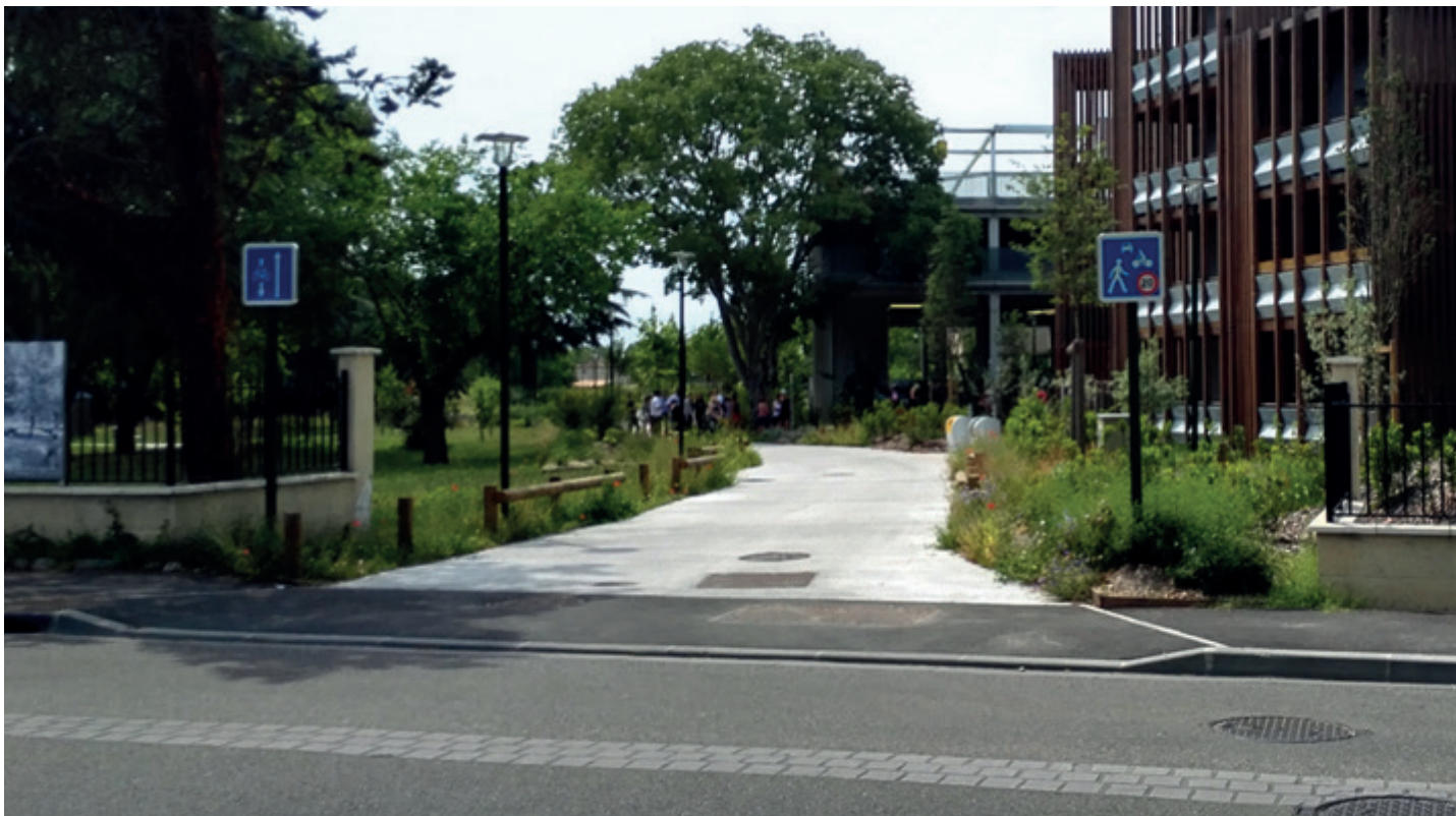
Entrée du quartier en zone de rencontre : trottoir traversant et changement de matériau et de couleur pour la chaussée partagée.
