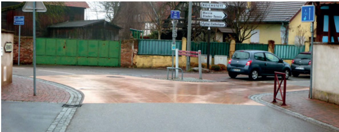
Le carrefour en priorité à droite a été mis en évidence grâce à une teinte différente de la chaussée. Un caniveau en pavés délimite les trottoirs. Le choix de cette délimitation facilite la giration d'un éventuel poids lourd (déménagement, collecte des ordures ménagères, chantier, ...).
