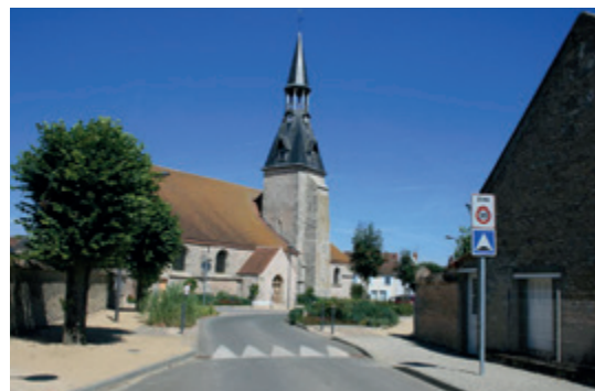
Ici, l'entrée de la zone 30 est marquée par une réduction de la largeur de la chaussée ainsi qu'une surélévation. Des végétaux bas (pour conserver la visibilité entre usagers) renforcent le rétrécissement de la chaussée et changent l'ambiance de la rue.
