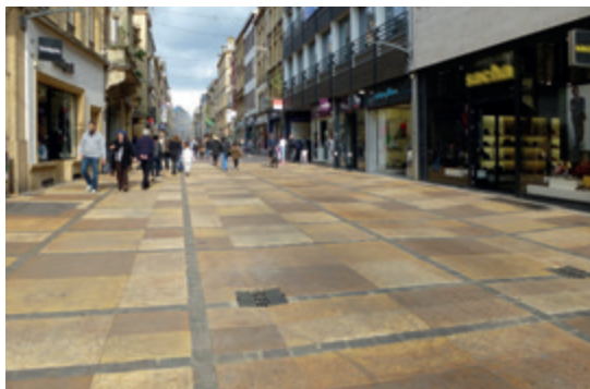
Ici, pour gommer l'image routière de cette rue du centre-ville, le sol a été entièrement rénové, transformé en damier de façade à façade. Les dalles rappellent la couleur de la pierre de Jaumont (pierre locale).
