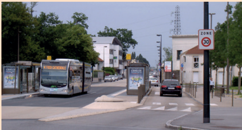
Sur cet axe principal de la ville, en zone 30, l'aménagement permet la circulation d'une ligne de bus à haut niveau de service, tout en respectant les contraintes de cette zone.
