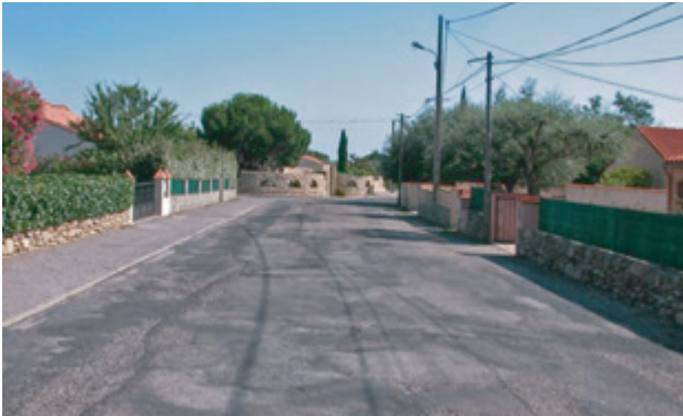
Rue des Oliviers existante
