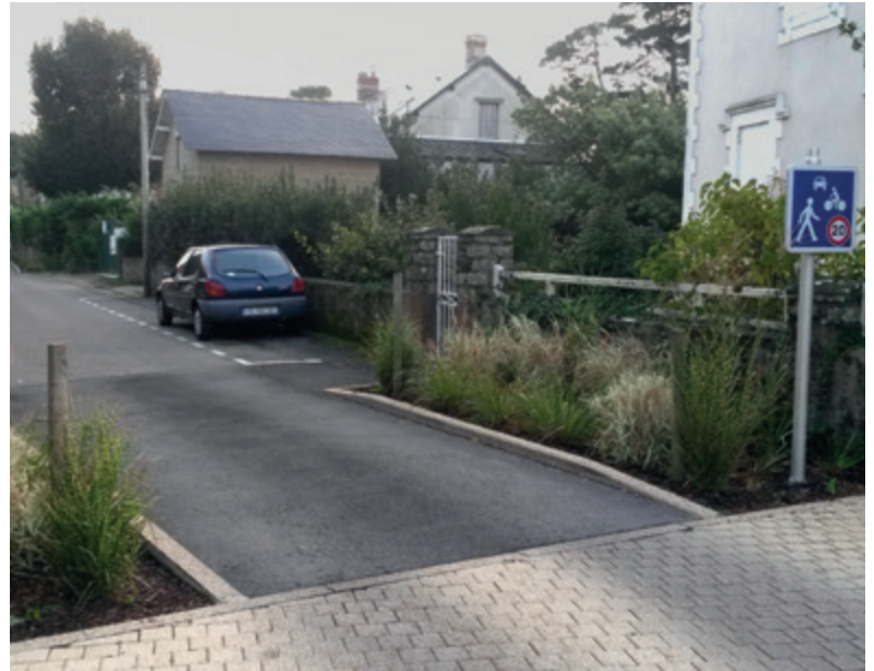
Dans cette rue de quartier résidentiel, la chaussée existante est une voirie mixte, à niveau de façade à façade. La mise en zone de rencontre a été accompagnée par l'aménagement d'un trottoir traversant et d'une écluse en entrée de zone avec l'ajout de plantations. Des places de stationnement sont matérialisées ponctuellement et en alternance.
