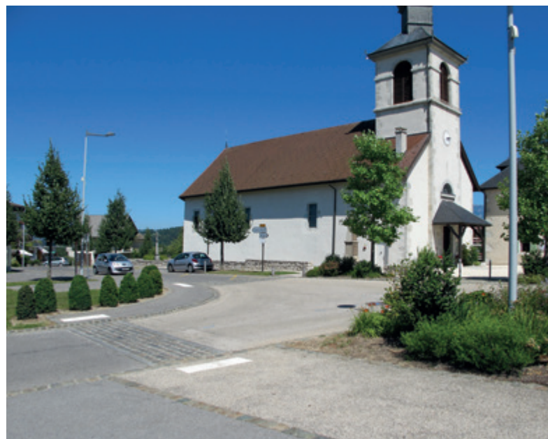
Intersection traitée avec une priorité à droite. Changement de couleur du revêtement en intersection. Les traversées piétonnes sont matérialisées par un revêtement spécifique et des bandes d'éveil à la vigilance.
