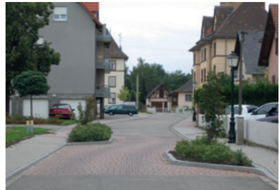
Sur cet exemple, il s'agit d'une écluse double dans une rue de quartier, soulignée par la végétation. Attention, le fil d'eau a été modifié par cet aménagement.
