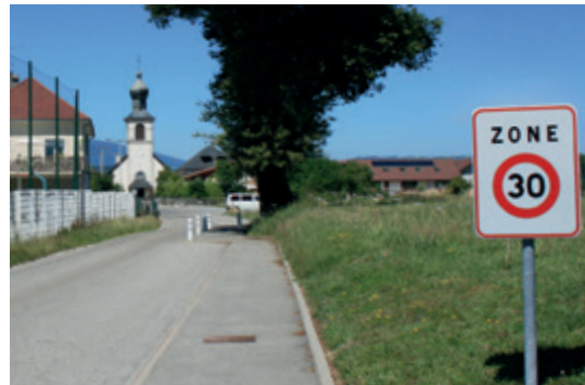
Entrée de zone 30 : utilisation d'éléments présents pour appuyer l'entrée de la zone. Ici, l'arbre est utilisé pour créer un rétrécissement. L'écluse est contraignante dans le sens entrant.
