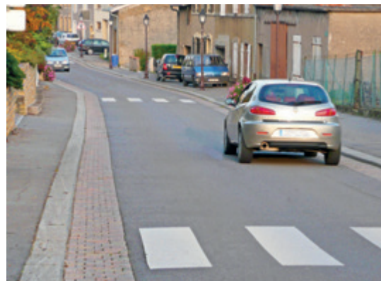
Les bandes latérales, en un revêtement différencié, forment un caniveau pour le recueil des eaux pluviales et réduisent visuellement la largeur de la chaussée.
