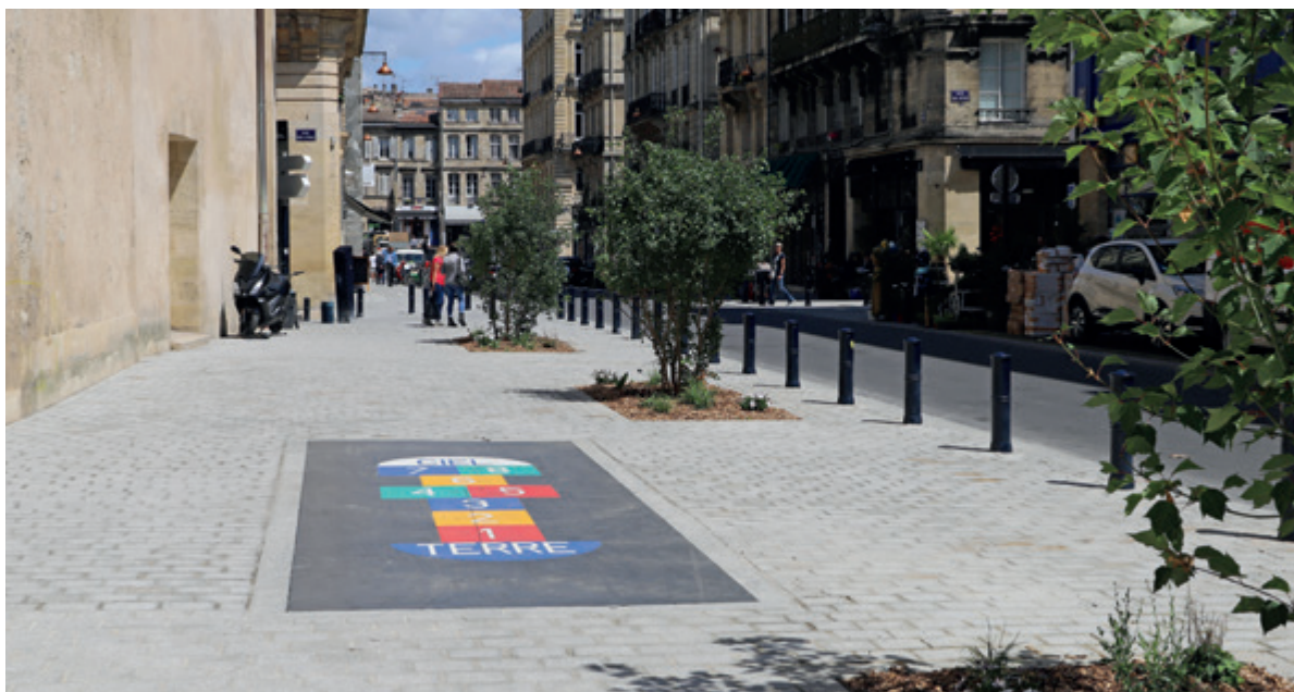
Large trottoir avec un espace de jeu, à plat, ne créant pas d'obstacle au cheminement et permettant de « ludifier » ponctuellement son déplacement ou de s'arrêter.
