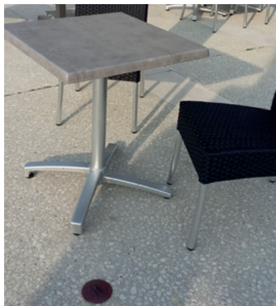
Ici, un élément discret a été mis en place pour délimiter la surface des terrasses dans une aire piétonne. Il s'agit de clous métalliques.
