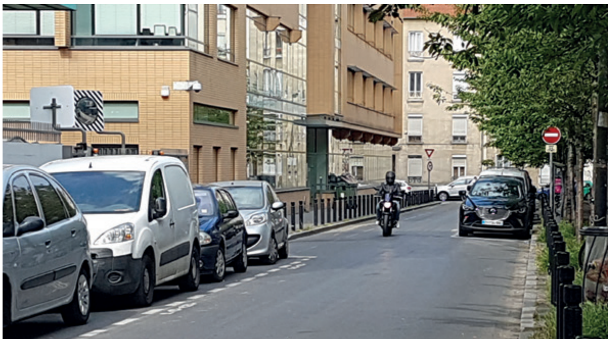
Organisation du stationnement pour créer une chicane dans cette rue à sens unique pour les véhicules motorisés.
