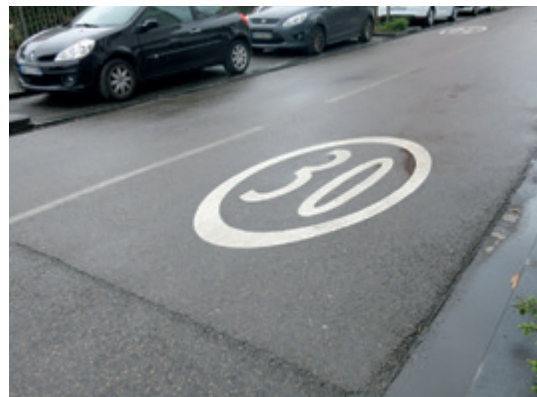
Marquage de rappel à l'intérieur d'une zone 30, positionné au centre de la voie de circulation, dans le sens de circulation des véhicules motorisés.
